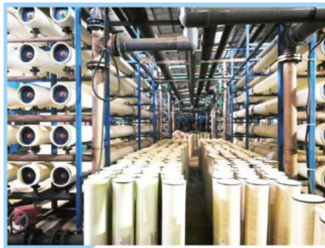
金海钛业4*140吨/小时改造、检修、更换滤料及膜元件
