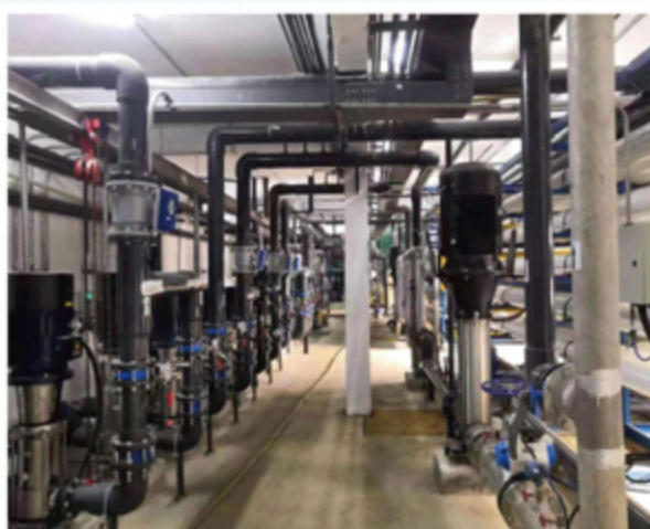
北营钢铁2*120吨/小时反渗透设备，采用AO+MBR+RO工艺，符合生产回用水标准
