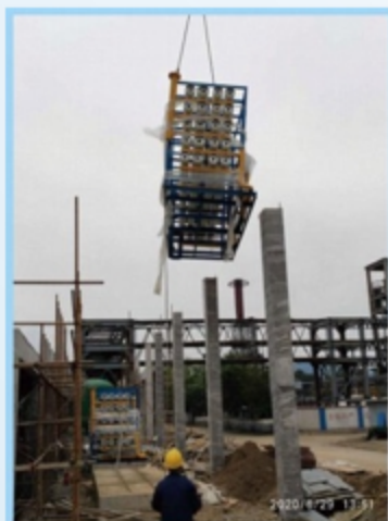
北营钢铁2*120吨/小时反渗透设备，采用AO+MBR+RO工艺，符合生产回用水标准
