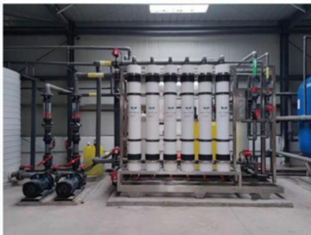
山东朗诺制药150吨/天零排放处理设备
