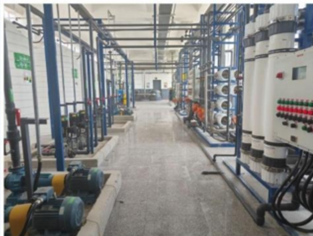
江苏博清环境科技150吨除盐水设备，过滤+超滤+双级反渗透工艺
