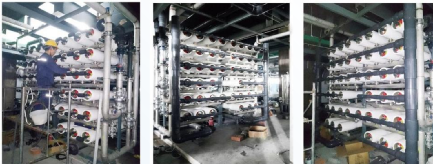
福建紫金锂元材料240吨反渗透设备维护改造
