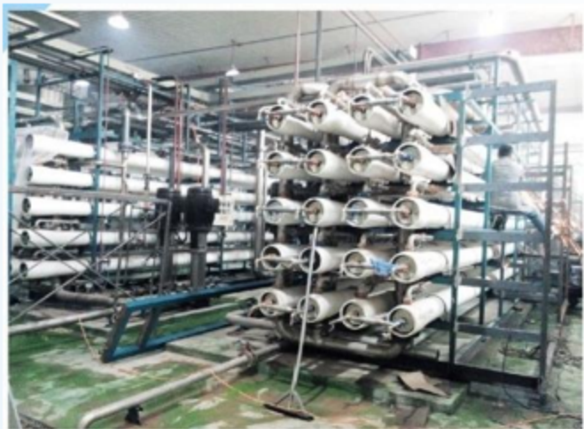
康师傅水厂2*60吨/小时扩容改造、检修、更换滤料，使产水达到2*90吨/时
