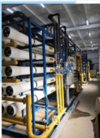
北营钢铁2*120吨/小时反渗透设备，采用AO+MBR+RO工艺，符合生产回用水标准
