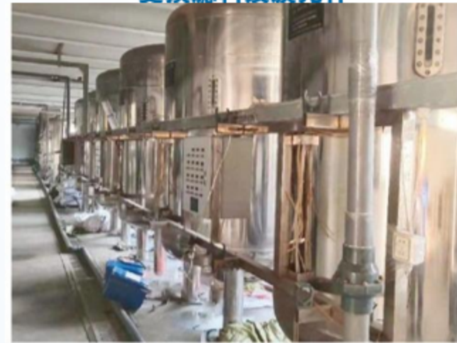
南京工厂机械过滤器改造 机械过滤器机组改造，更换过滤器 滤料及配套阀门
