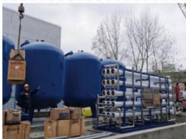
中国航天科技50吨/小时纯水设备， 采用双级反渗透技术
