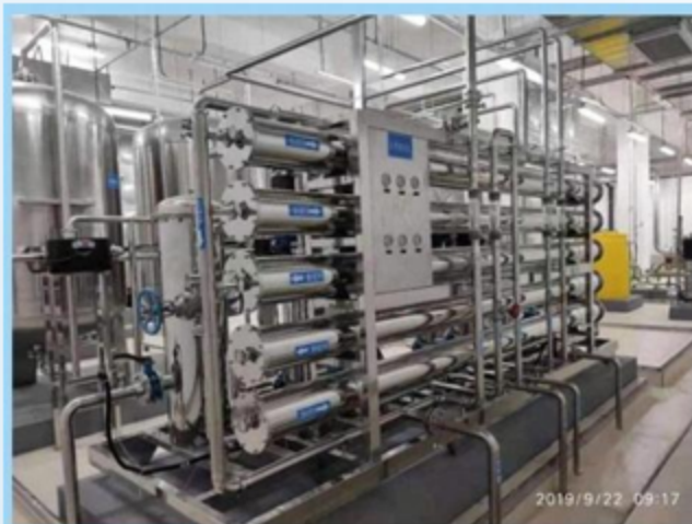
北京大兴机场340吨/小时软化水及40吨/小时纯净水设备，符合生产生活用水标准
