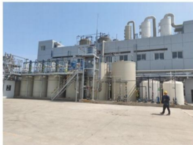
江苏博清环境科技150吨除盐水设备，过滤+超滤+双级反渗透工艺
