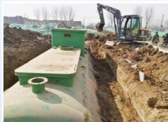
槐荫区玉清湖500吨/天一体化生活污水处理设备移机、检修更换MBR膜
