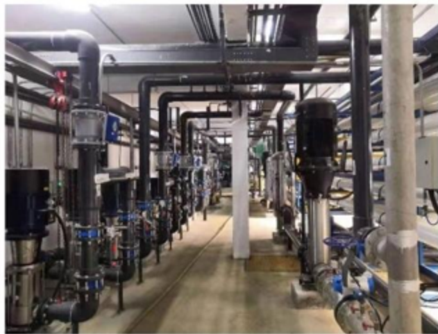
辽宁本溪北营焦化2*120吨/小时反渗透设备
