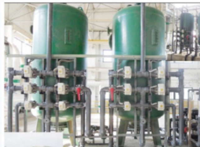
通用汽车2*30吨/小时软化，钠型007阳树脂处理工艺，符合软化用水要求
