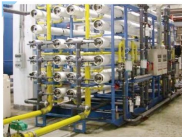
龙力生物120吨/小时反渗透设备，所用水 质符合行业用水标准(长期合作关系)
