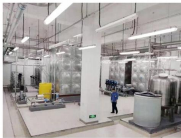
北京大兴机场340吨/小时软化水及40吨/小时纯净水设备，符合生产生活用水标准
